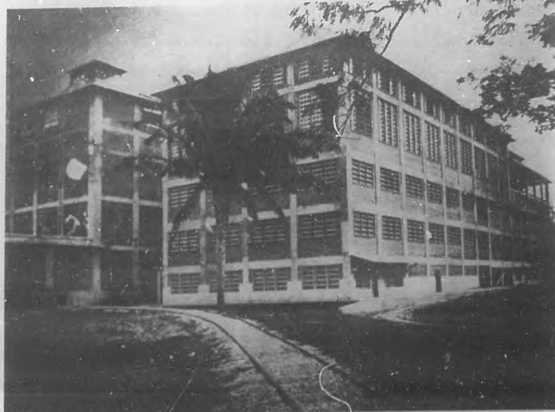
EL "PACKING-HOUSE" DE COVEÑAS.— Vista del Abattoir o Matadero donde pueden sacrificarse cómodamente unas 500 reses diarias.
